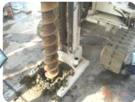
螺旋鑽鑽孔
